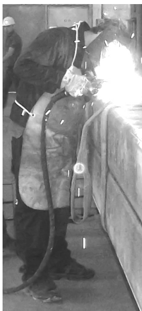
Figura 8. Operatore addetto alla saldatura.
